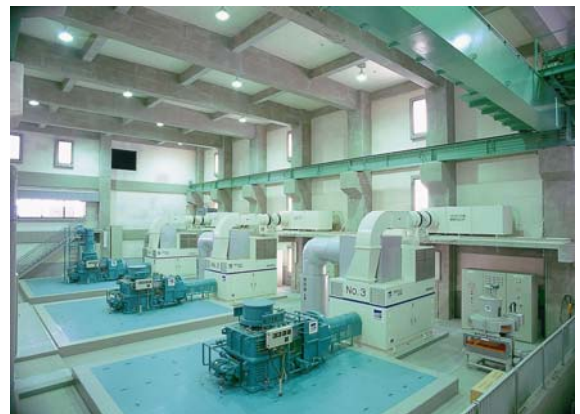
写真4.2.1 高橋排水ポンプ場
