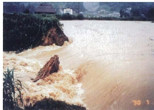
② 武雄市橘町での堤防の決壊状況（永島地区）
