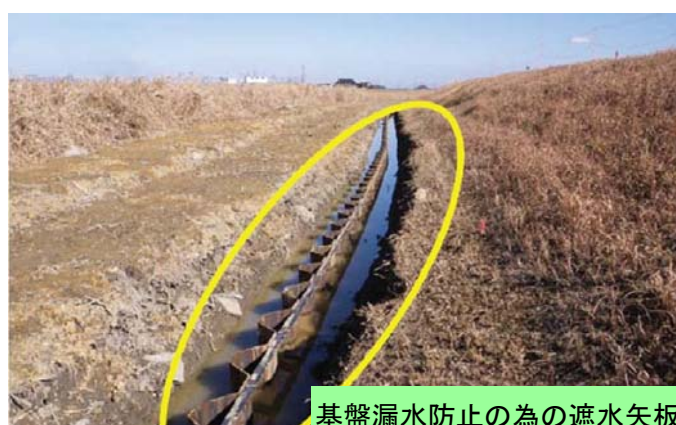
写真2.1.3 堤防基盤漏水への対策事例
