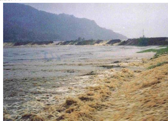
④ 多久市東多久町での堤防からの越水状況（納所地区） のうそ
