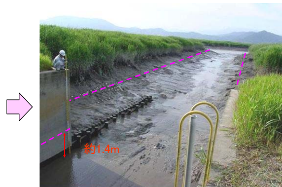
写真 2.1.11 ガタ土除去後の状況
