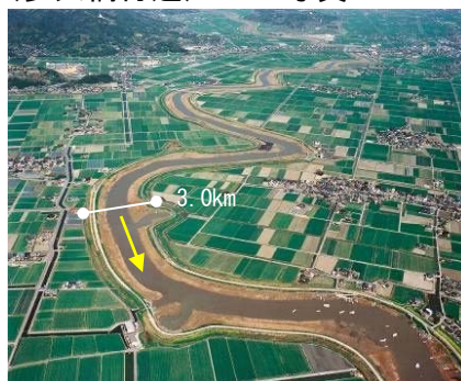
写真 1.1.8 牛津川下流部（3.0km 付近）
