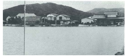
写真 1.2.4 杵島郡江北町での内水被害 (惣領分・馬場地先)〔昭和 47 年 7 月〕
