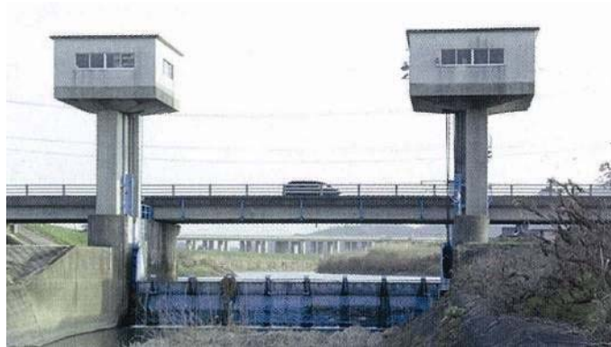
写真 1.2.15 大日堰 (昭和 57 年 3 月完成)
