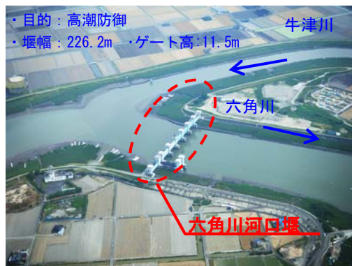
写真 1.2.21 六角川河口堰(昭和 58 年 3 月完成)
