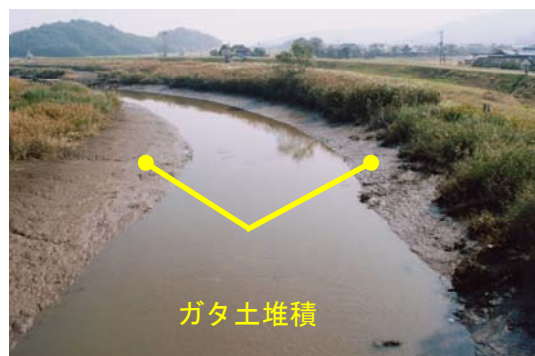
写真 1.1.1 ガタ土堆積状況
