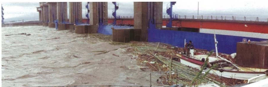
写真 2.1.7 昭和 60 年台風 13 号での高潮防御状況
