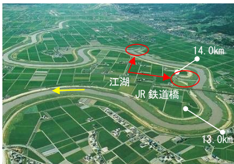
写真 1.1.4 六角川下流部（JR 鉄道橋付近）
