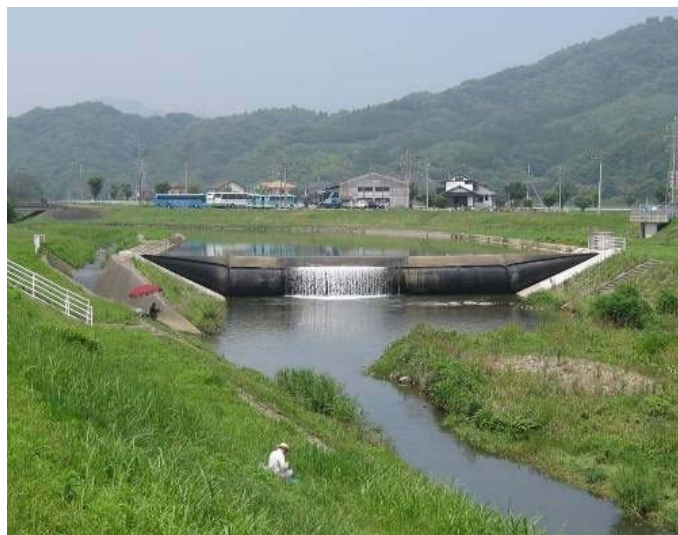
写真 1.2.16 小井手堰 (平成 17 年 3 月完成)
