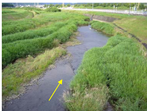
写真 2.3.29 連続する瀬と淵 (牛津川 23.0km 付近)
