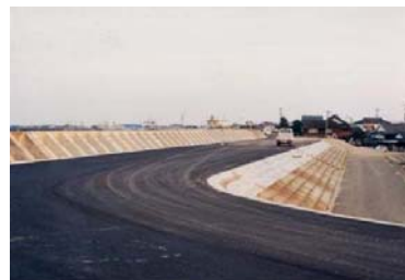
写真 1.2.20 高潮堤防の整備
