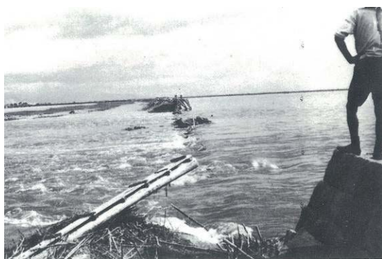
写真 1.2.11 旧福富町昭和堀でのはん濫状況 (昭和 34 年 9 月台風 14 号)
