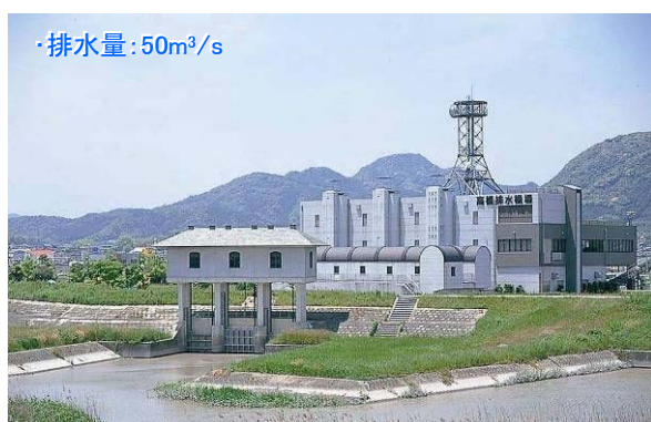
写真 1.2.18 高橋排水ポンプ場 (平成9年3月完成)
