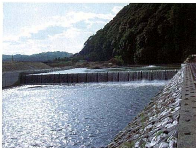
写真 1.2.17 大井手堰 (平成 17 年 1 月完成)
