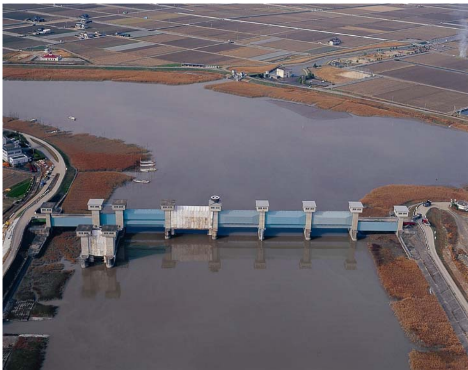
写真4.3.4 六角川河口堰の状況
