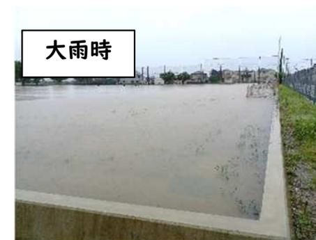
↑【整備事例】学校グラウンドの外周をコンクリート擁壁で囲むことで、大雨時に雨水をグラウンド内に雨水を貯留
