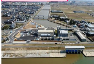
排水機場と周辺の市街地
