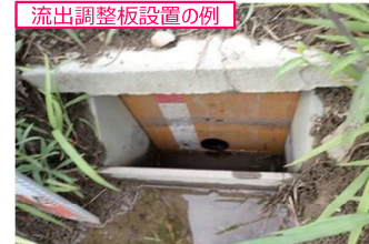
流出調整板設置の例
