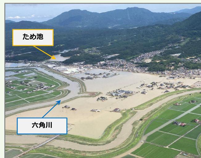
▲ 豪雨による被災状況
