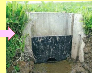
調整版設置状況
