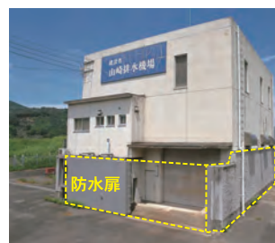
防水壁の設置
