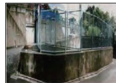
従前の防災調整池
