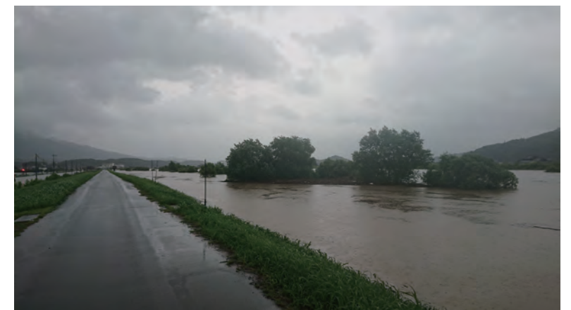
河道内樹木による流下阻害状況
