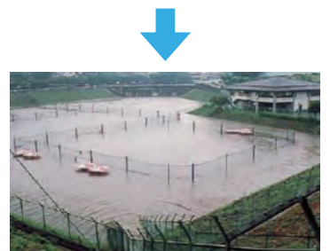
雨水貯留施設（公園貯留）
