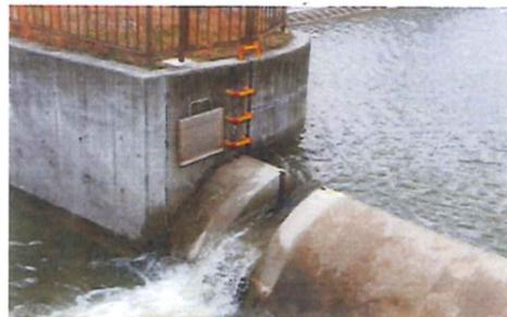
洪水吐きスリットの設置の例
