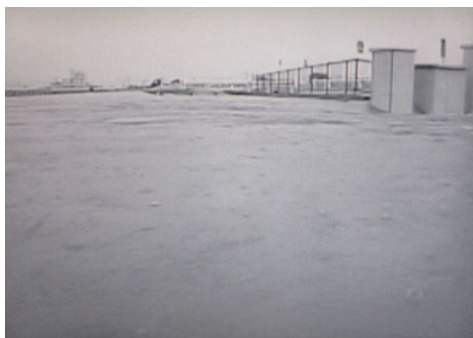
幹線用水路の溢水状況 (令和3年8月豪雨)
