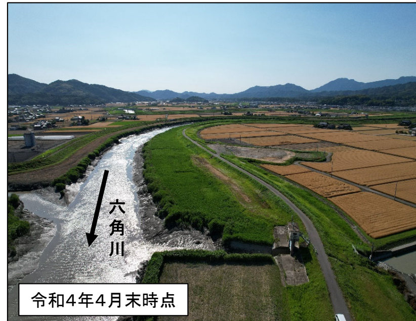
③大町町管内での取組み(ヨシ繁茂抑制対策)
