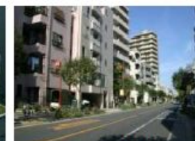
沿道建築物の不燃化
