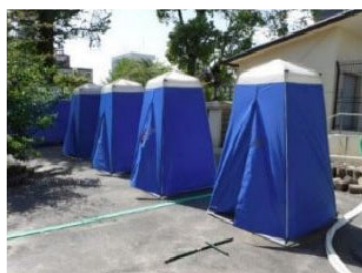
マンホールトイレ(熊本市)
