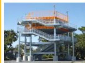
津波避難タワー
