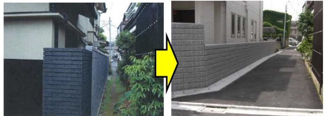
避難路整備(道路の拡幅)
