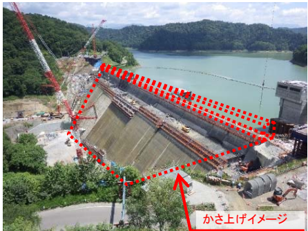
ダム建設・ダム再生
