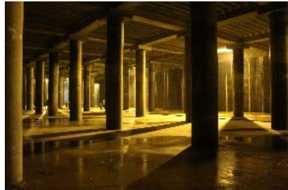
大規模地下貯留施設(下水道)
