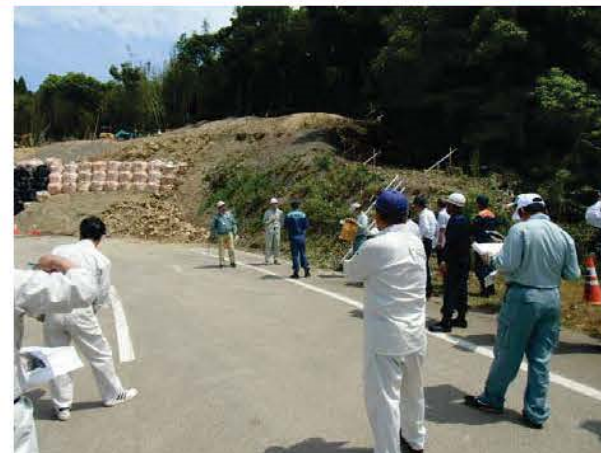
臨港道路福田線災害復旧状況について説明している様子
