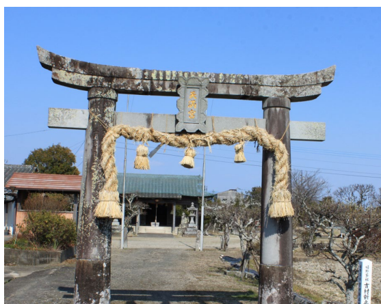
余震で倒壊した鳥居（白石町廿治 吉村天満宮）
