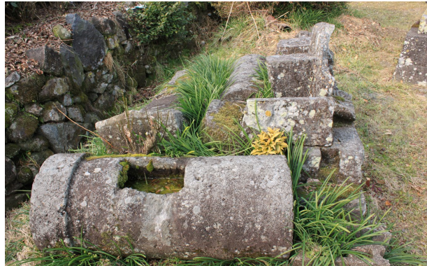
暴風で倒壊した鳥居の残骸（嬉野市 川上丹生神社）
