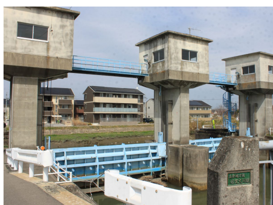
枝吉水門（昭和 61 年 3 月竣工）
