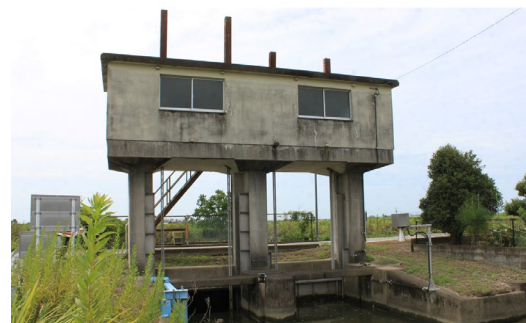
小松第1排水樋管
