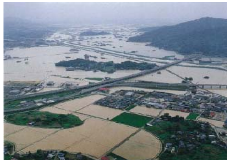
写真3 長崎自動車道 武雄 IC 付近浸水状況（平成21年7月）
