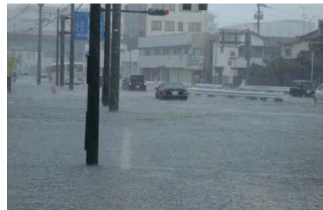
写真2 佐賀市内国道264号機動隊前交差点付近の浸水状況（平成21年7月）
