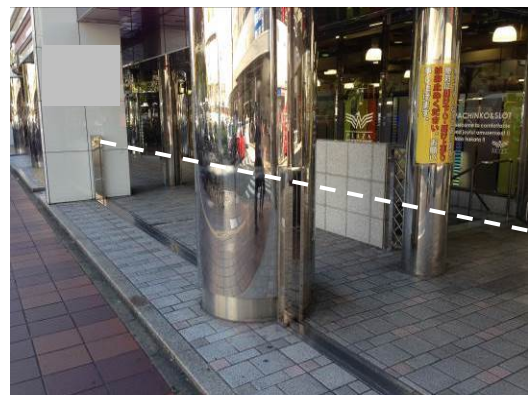
写真2 JR 博多駅入口付近の 浸水防止板設置枠(2/2)
