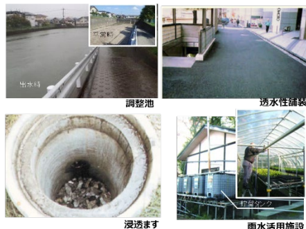
雨水貯留浸透施設の例
