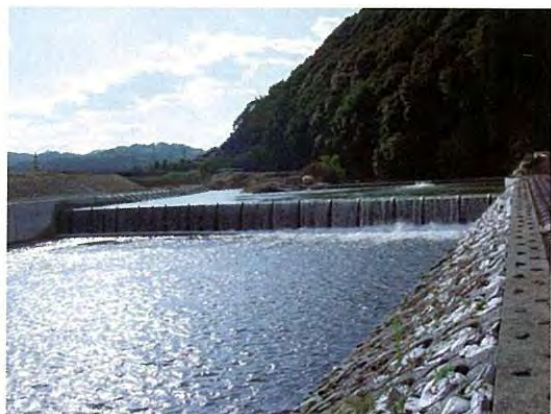
写真-1.11 大井手堰 (平成 17 年 1 月完成)
