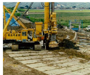
深層混合処理方法
