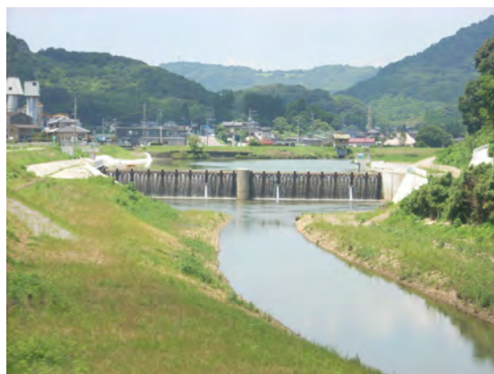
写真-1.12 鰐ノ瀬堰 (平成 26 年 5 月完成)
