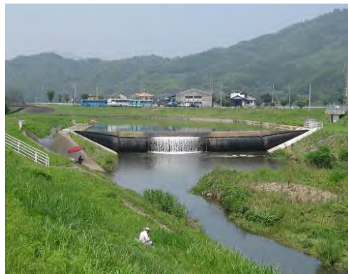
写真-1.10 小井手堰 (平成 17 年 3 月完成)
