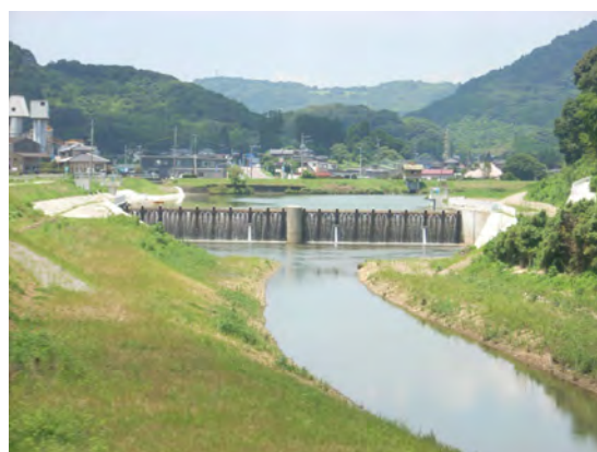
写真-1.12 鰐ノ瀬堰 (平成 26 年 5 月完成)
