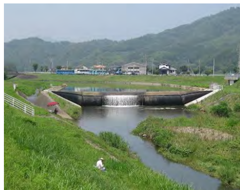
写真-1.10 小井手堰 (平成 17 年 3 月完成)
