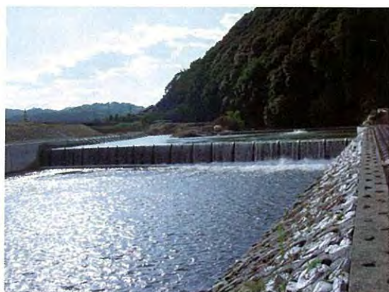
写真-1.11 大井手堰 (平成 17 年 1 月完成)
