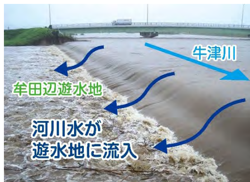
写真-1.7 平成 24 年 7 月洪水での 越水状況
