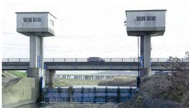
写真-1.9 大日堰 (昭和 57 年 3 月完成)
