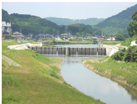
写真-1.12 鰐ノ瀬堰 (平成 26 年 5 月完成)
