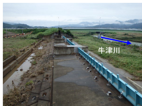
写真-1.8 牟田辺遊水地 越流堤の可動化状況
