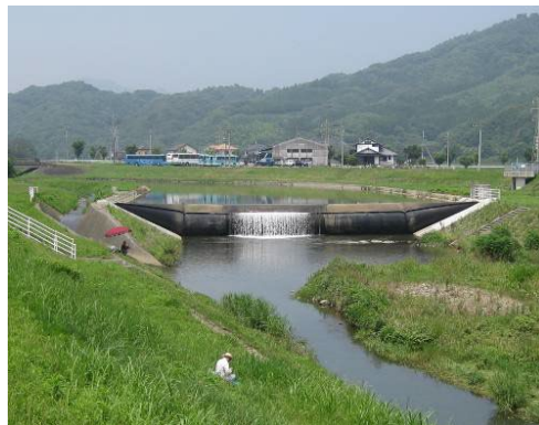
写真-1.10 小井手堰 (平成 17 年 3 月完成)
