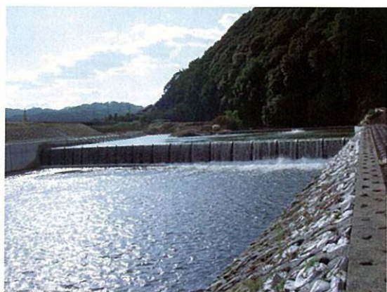
写真-1.11 大井手堰 (平成 17 年 1 月完成)
