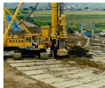
深層混合処理方法
