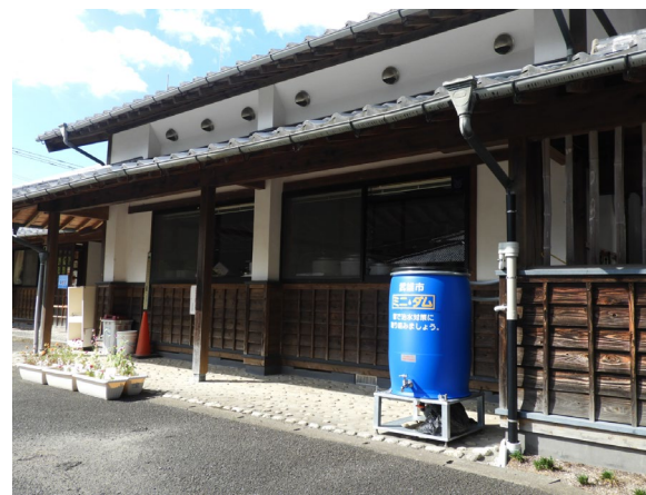
【雨水貯留タンクの設置】
