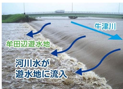
写真-1.7 平成24年7月洪水での越水状況
