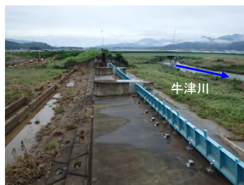
写真-1.8 牟田辺遊水地 越流堤の可動化状況
