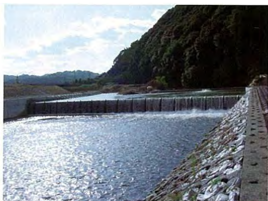
写真-1.11 大井手堰 (平成 17 年 1 月完成)
