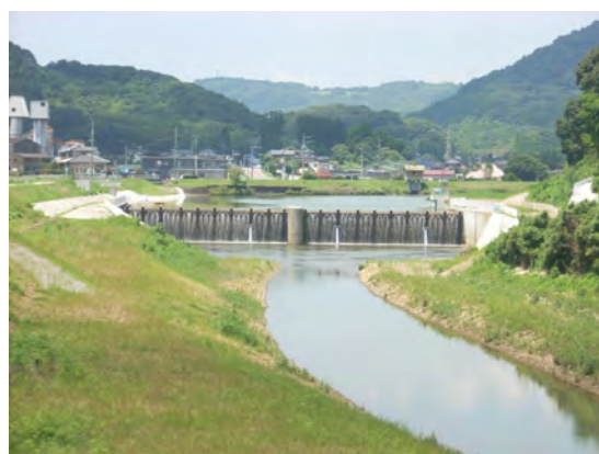
写真-1.12 鰐ノ瀬堰 (平成 26 年 5 月完成)
