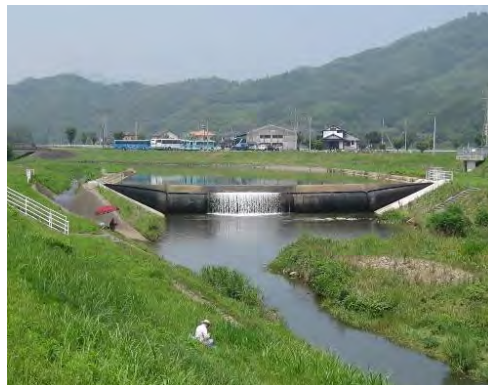
写真-1.10 小井手堰 (平成 17 年 3 月完成)
