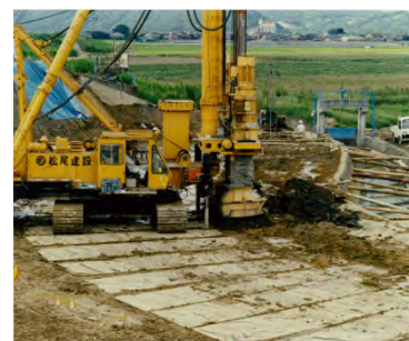
深層混合処理方法
