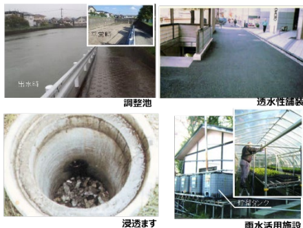
雨水貯留浸透施設の例
