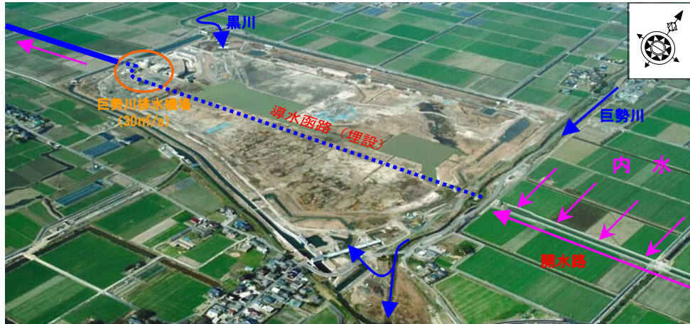
図 4-2-14 佐賀導水事業における巨勢川調整池の整備状況
