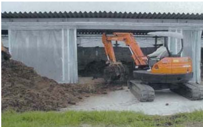
除草工事の刈草をリサイクル ＜公共工事に伴う 環境負荷低減の取り組み＞
