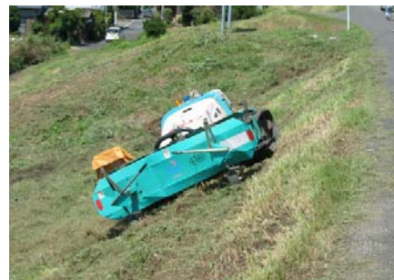
写真 4-3-3 遠隔操作による堤防除草作業
