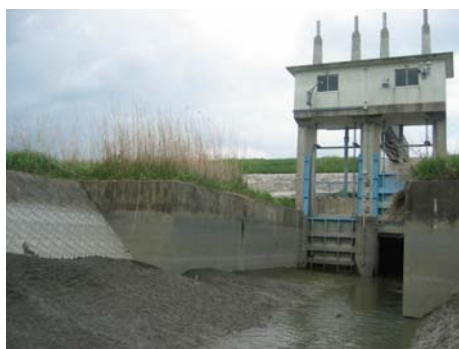
写真 4-3-7 感潮区間のガタ土 (得仏排水樋管)
