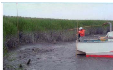
写真-4-3-5 ガタ土攪拌除去実施状況
