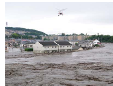
写真- 2.2.11 熊本市龍田陣内地区の越水状況
