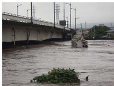
写真- 2.2.10 蓮台寺橋地点の流下状況
