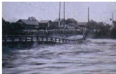
写真- 2.2.1 流失直前の明午橋
