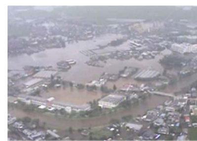
写真- 2.2.13 阿蘇市内牧市街部の浸水状況
