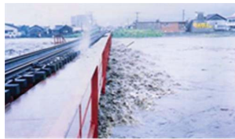
写真- 2.2.7 第一白川橋梁地点の流下状況
