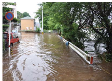
写真- 2.2.8 明午橋右岸上流の越水状況
