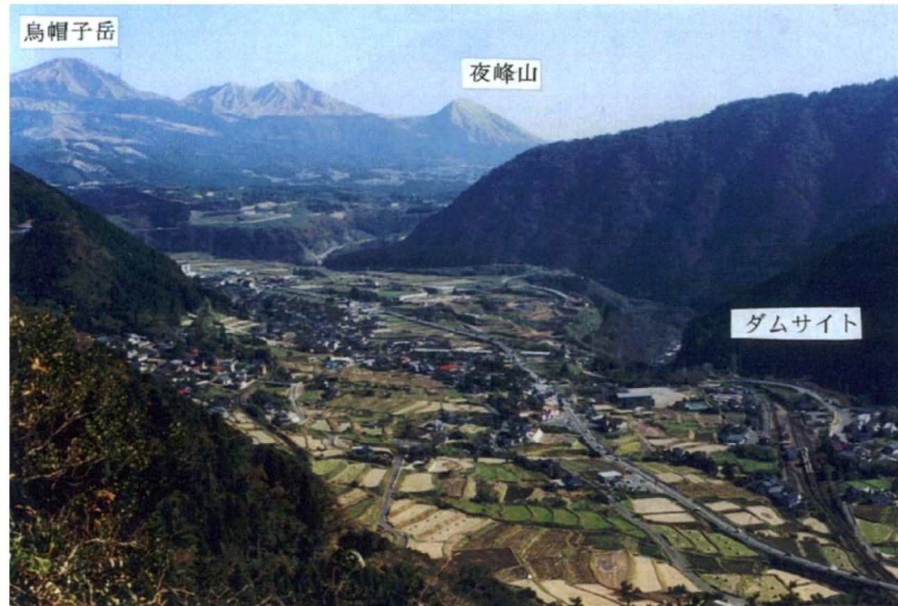
写真-3.2.1 立野火口瀬周辺の地形(下流側右岸の尾根よりダムサイトを望む)
