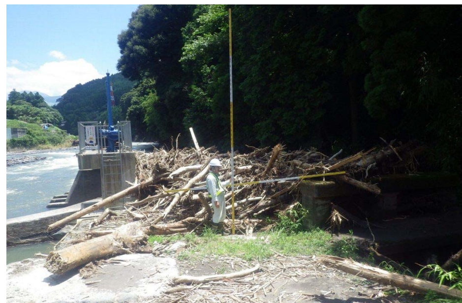
写真-6.2.4 畑井手堰流木状況
