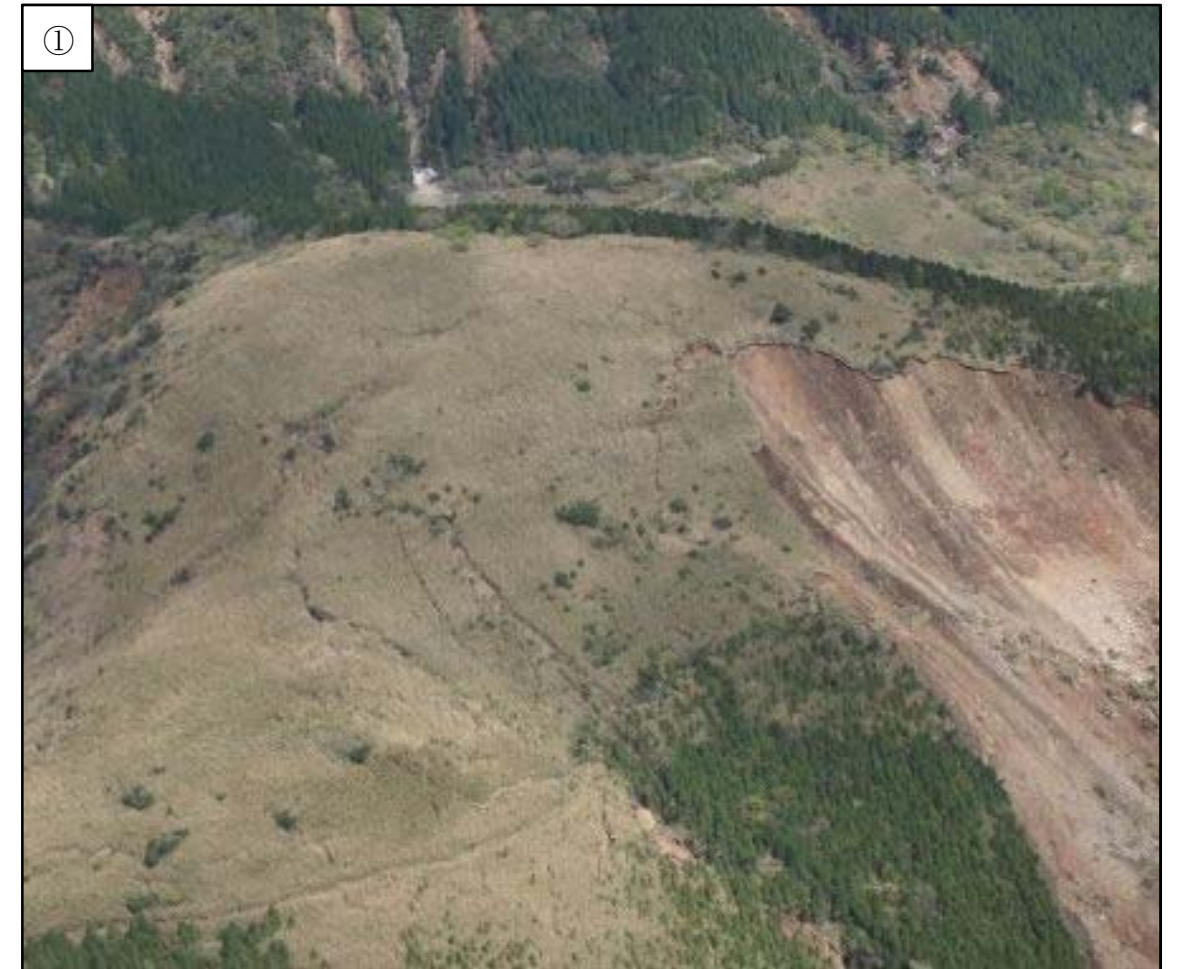
写真-6.4.2 斜面崩壊上部の亀裂状況（阿蘇大橋付近）
