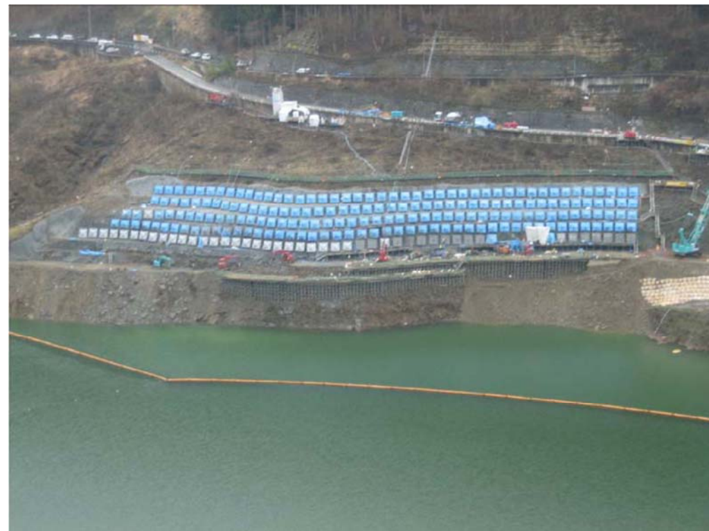
写真-6.4.1 対策工状況 (盆栽山地区)
