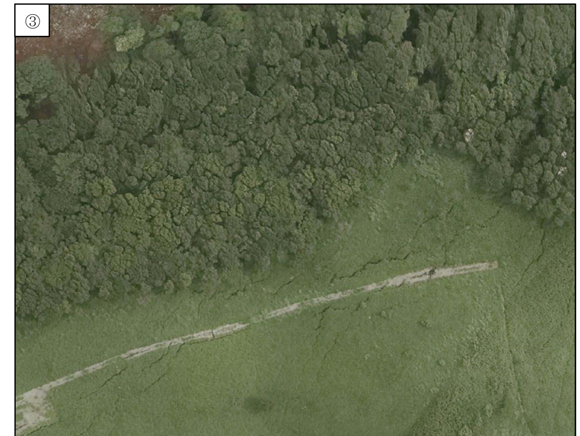
写真-6.4.4 斜面崩壊上部の亀裂状況（ダムサイト左岸上部）
