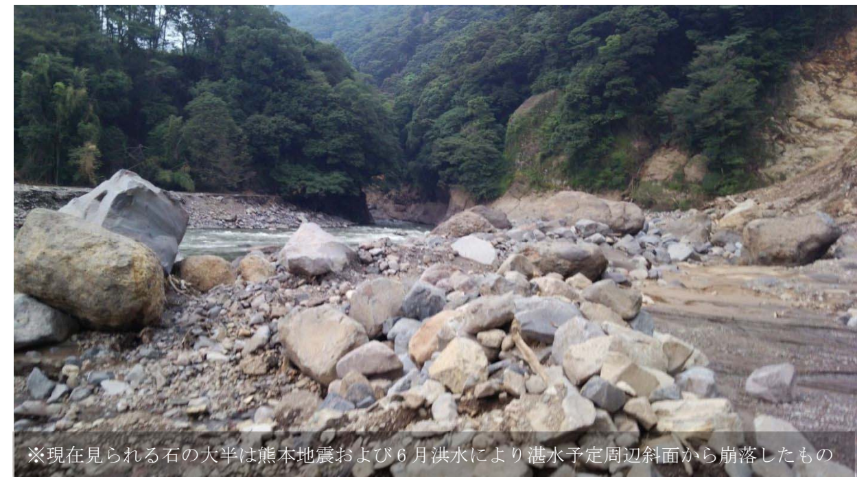
写真-6.3.3 河川内の巨石状況
