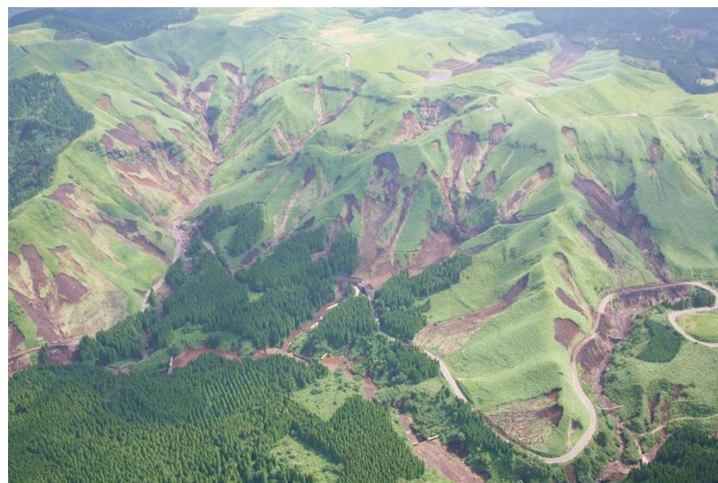
写真-6.1.1 斜面崩壊状況 (H24九州北部豪雨)
