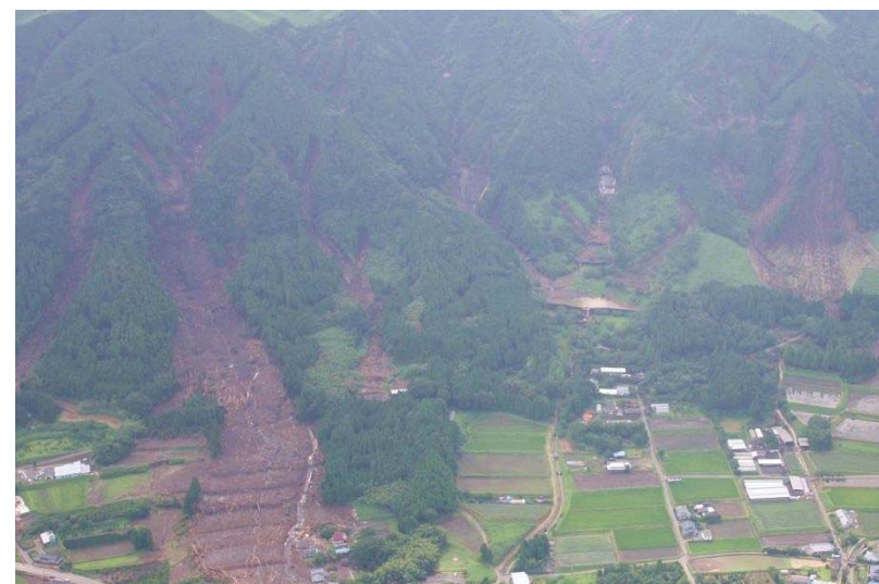
写真-6.1.2 斜面崩壊状況 (H24九州北部豪雨)
