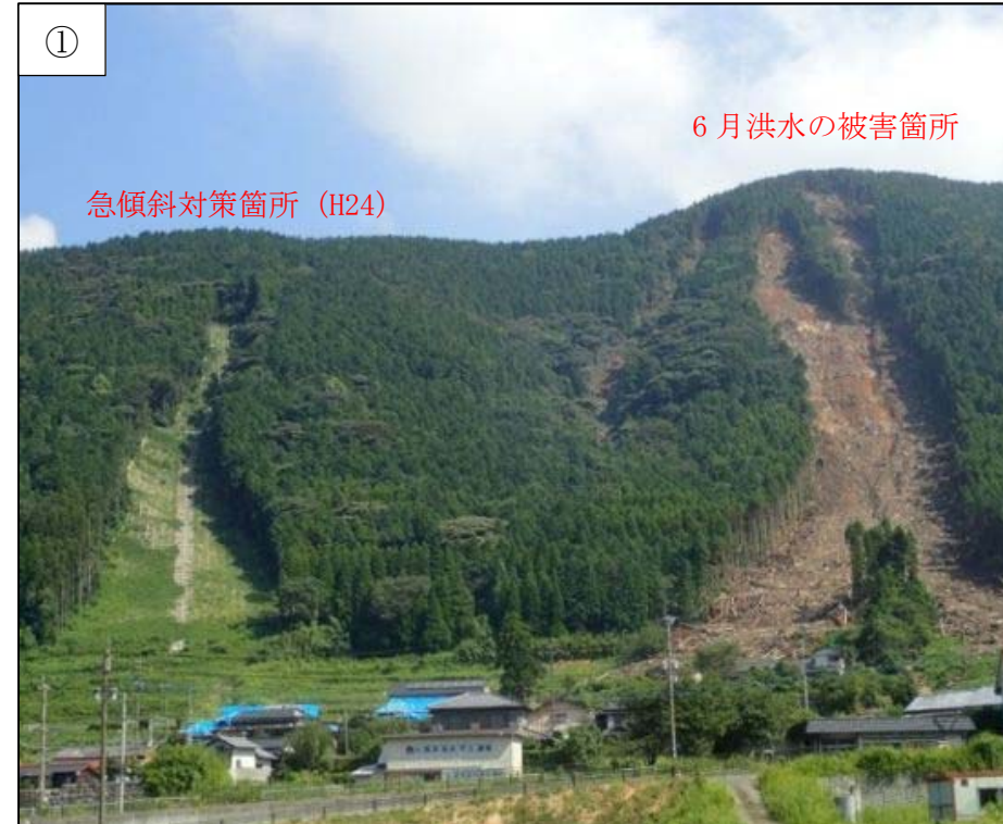
写真-6.1.3 斜面对策状況①
