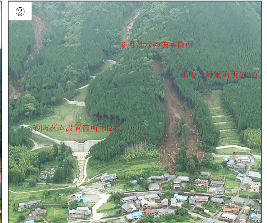
写真-6.1.4 斜面对策状況②
