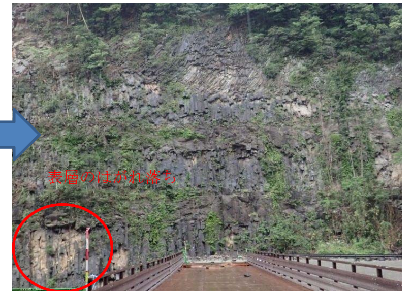
写真-5.3.3 ダムサイト右岸（地震後）
