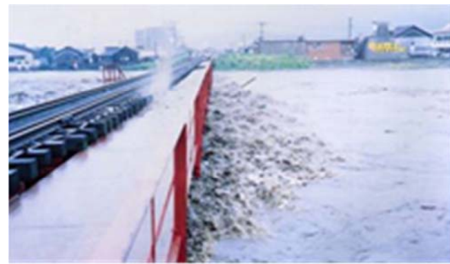
写真- 2.2.7 第一白川橋梁地点の流下状況
