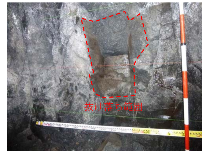
⑦入り口より 22.0m（下流側壁面）
