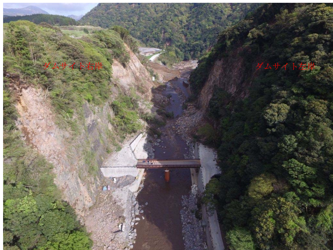
写真-5.3.1 ダムサイト状況（地震後）
