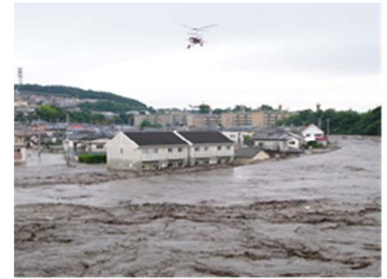
写真- 2.2.11 熊本市龍田陣内地区の越水状況
