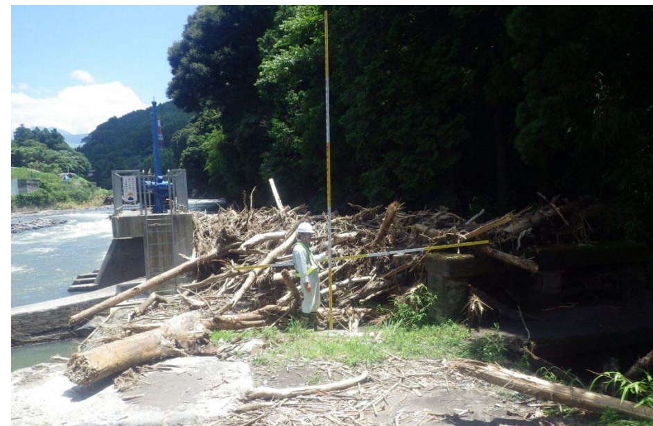
写真-6.2.4 畑井手堰流木状況
