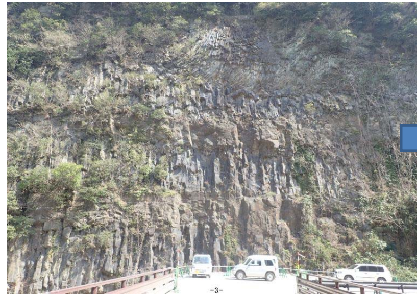
写真-5.3.2 ダムサイト右岸（地震前）
