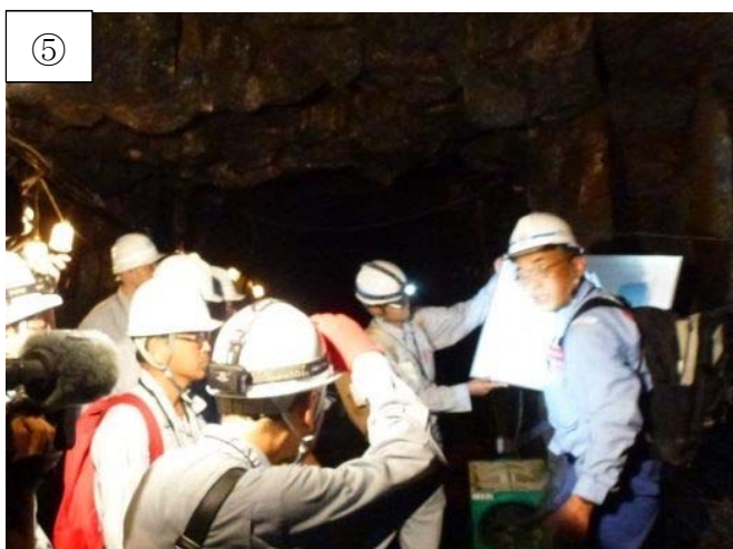
写真-1.3.9 横坑の確認状況
