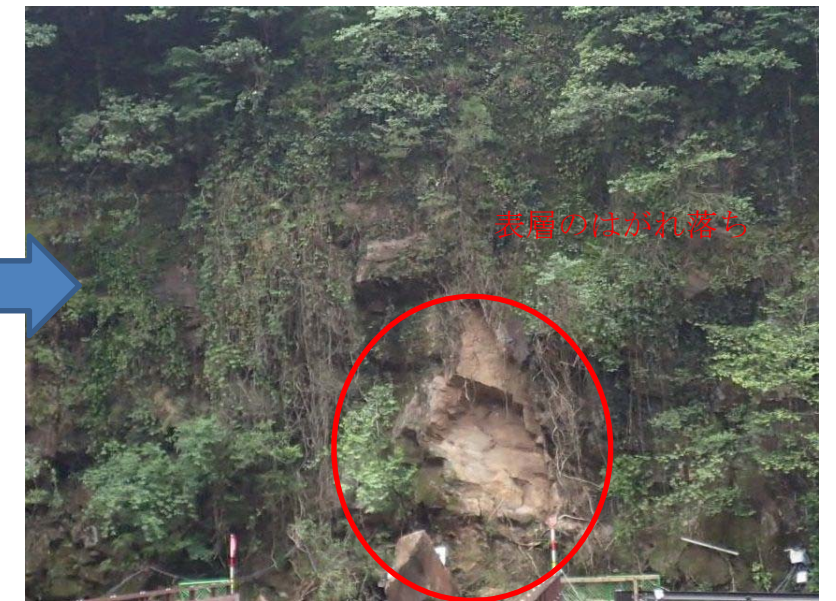
写真-5.3.5 ダムサイト左岸（地震後）
