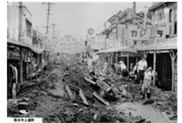
写真- 2.2.2 洪水後のヨナの堆積状況(熊本市上通町)
