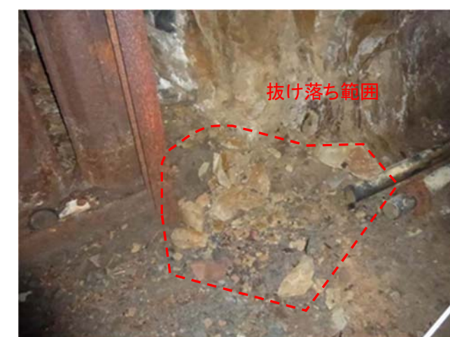
⑥入り口より 14.5m (下流側壁面)
