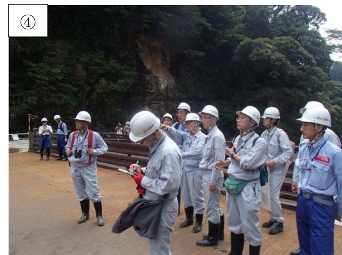
写真-1.3.8 基礎岩盤の確認状況
