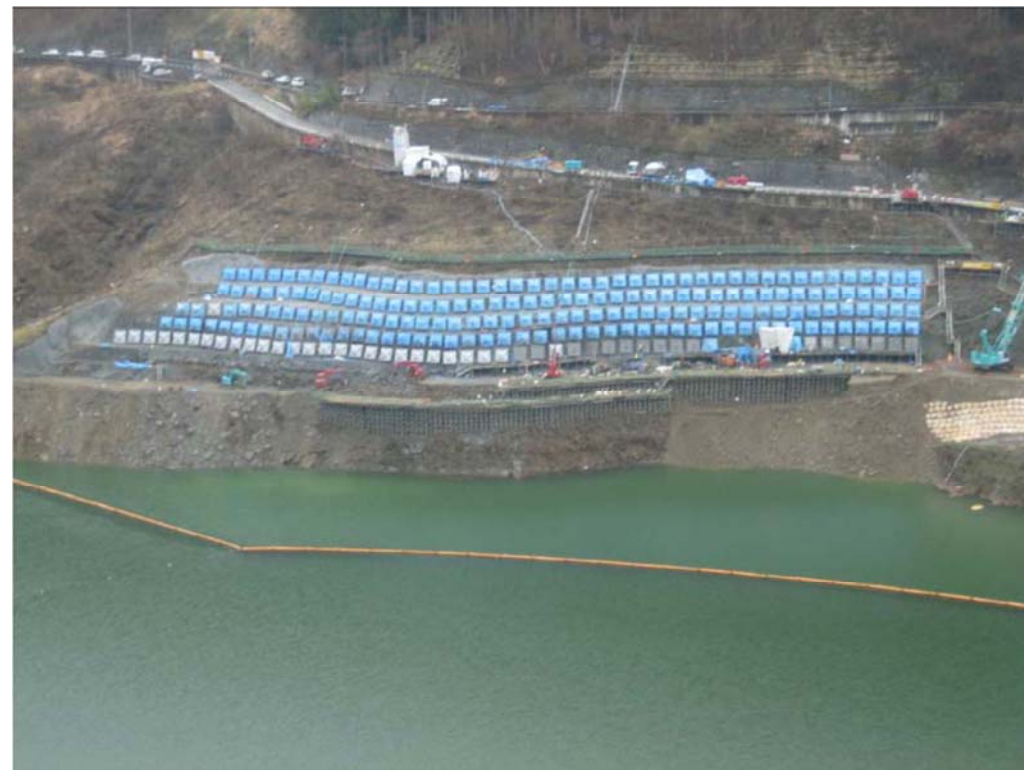
写真-6.4.1 対策工状況 (盆栽山地区)
