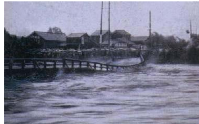
写真- 2.2.1 流失直前の明午橋
