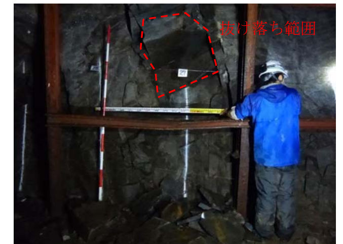
⑦入り口より 27.0m（下流側壁面）
