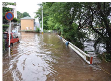
写真- 1.2.8 明午橋右岸上流の越水状況
