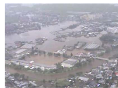
写真- 1.2.13 阿蘇市内牧市街部の浸水状況
