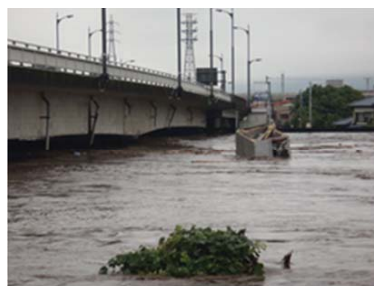
写真- 1.2.10 蓮台寺橋地点の流下状況
