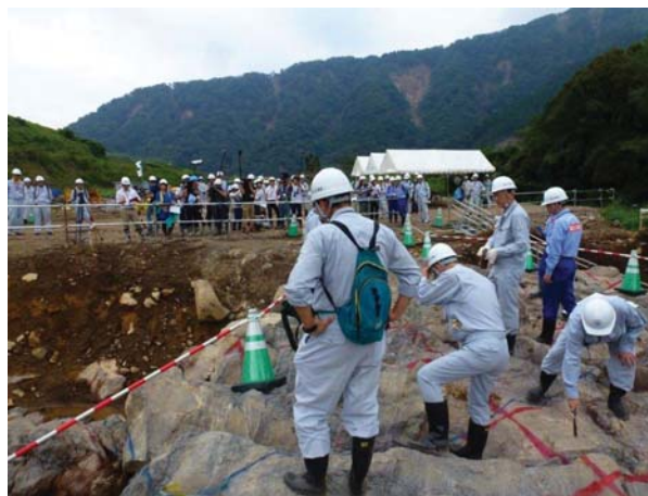
写真-4.3.9 調査状況
