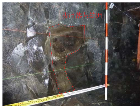
⑥ 入り口より 6.0m（上流側壁面）
