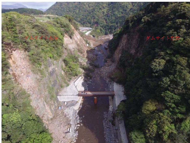
写真-4.3.1 ダムサイト状況（地震後）
