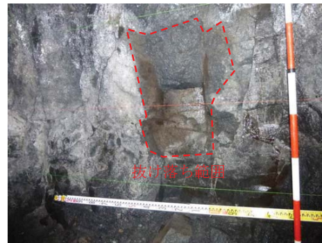
⑦ 入り口より 22.0m（下流側壁面）
