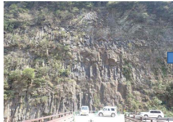
写真-4.3.2 ダムサイト右岸（地震前）
