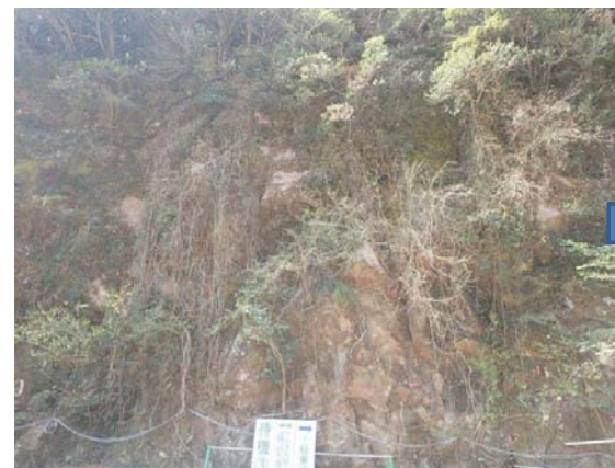
写真-4.3.4 ダムサイト左岸（地震前）
