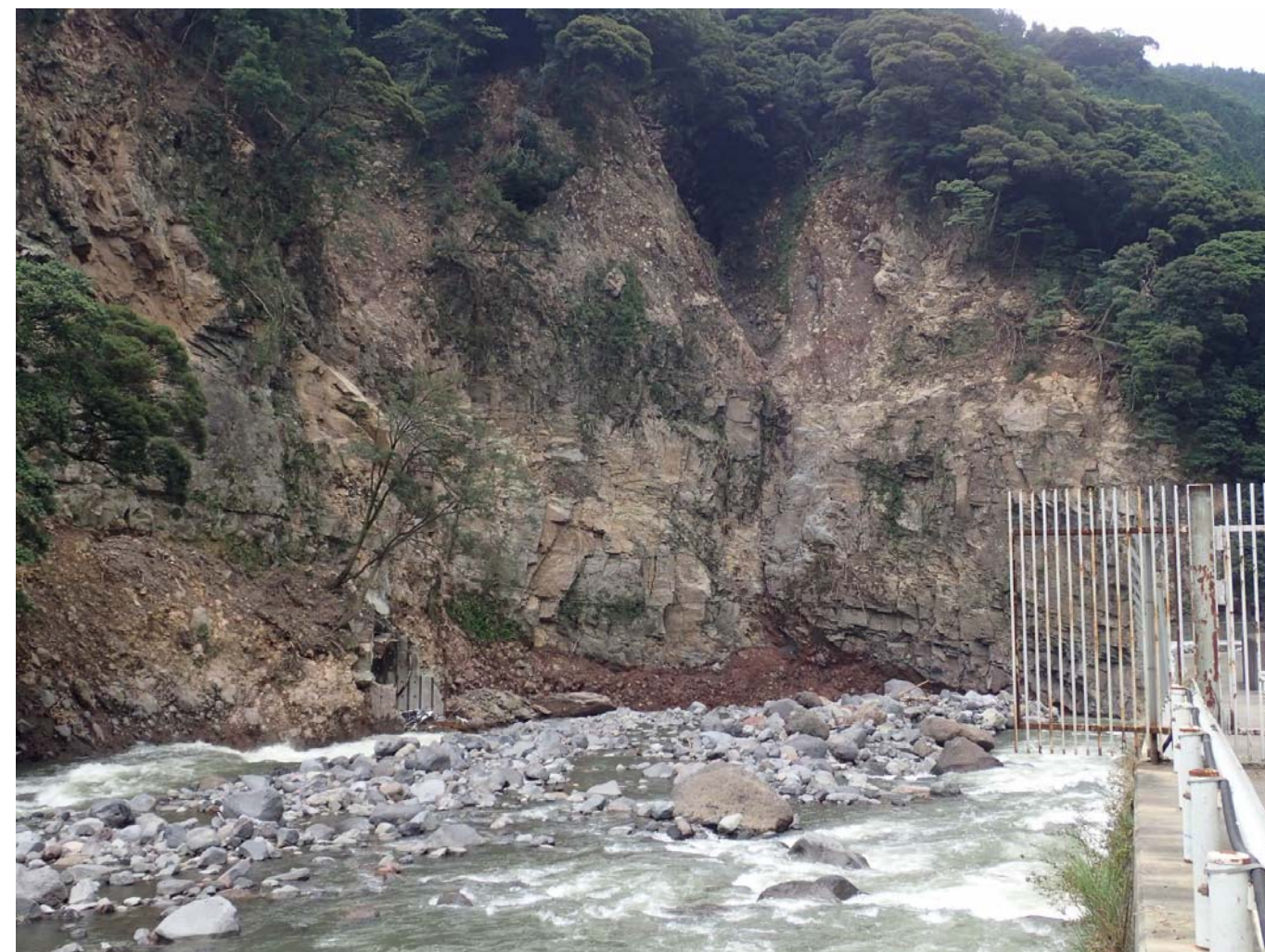
写真-3.2.3 文献断層 25 延長部の岩盤露頭
