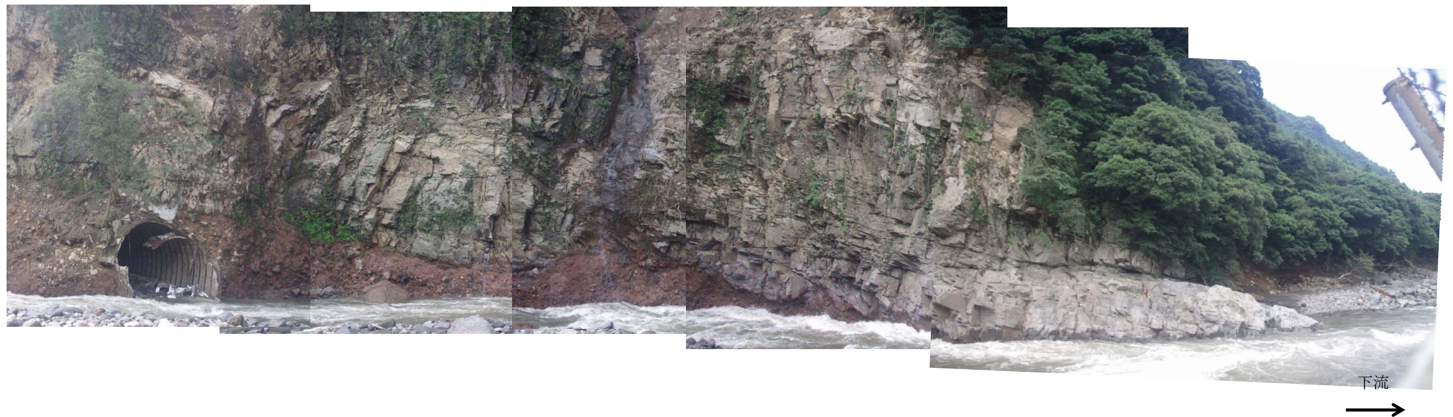
写真-3.2.2 文献断層 25 延長部の連続露頭 2
