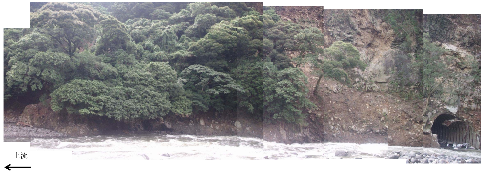
写真-3.2.1 文献断層 25 延長部の連続露頭 1
