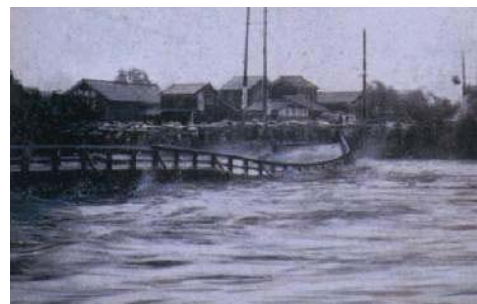
写真- 1.2.1 流失直前の明午橋
