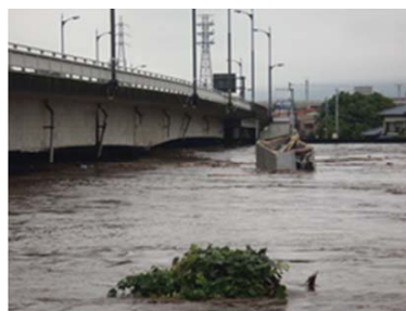
写真- 1.2.10 蓮台寺橋地点の流下状況
