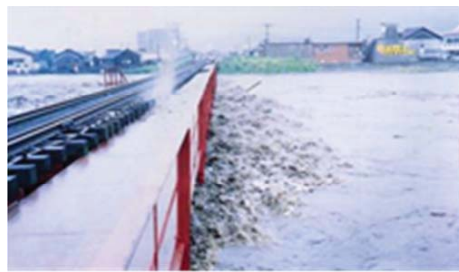
写真- 1.2.7 第一白川橋梁地点の流下状況
