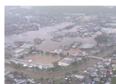
写真- 1.2.13 阿蘇市内牧市街部の浸水状況
