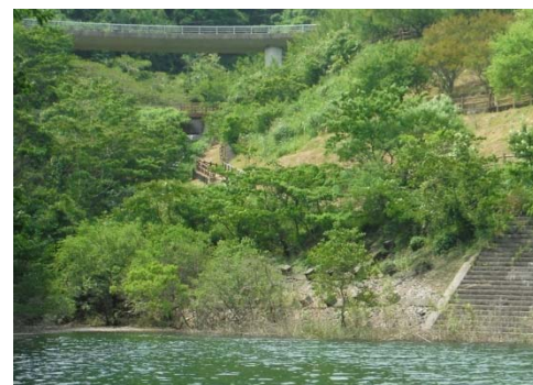
対策工事例②(Bダム)
