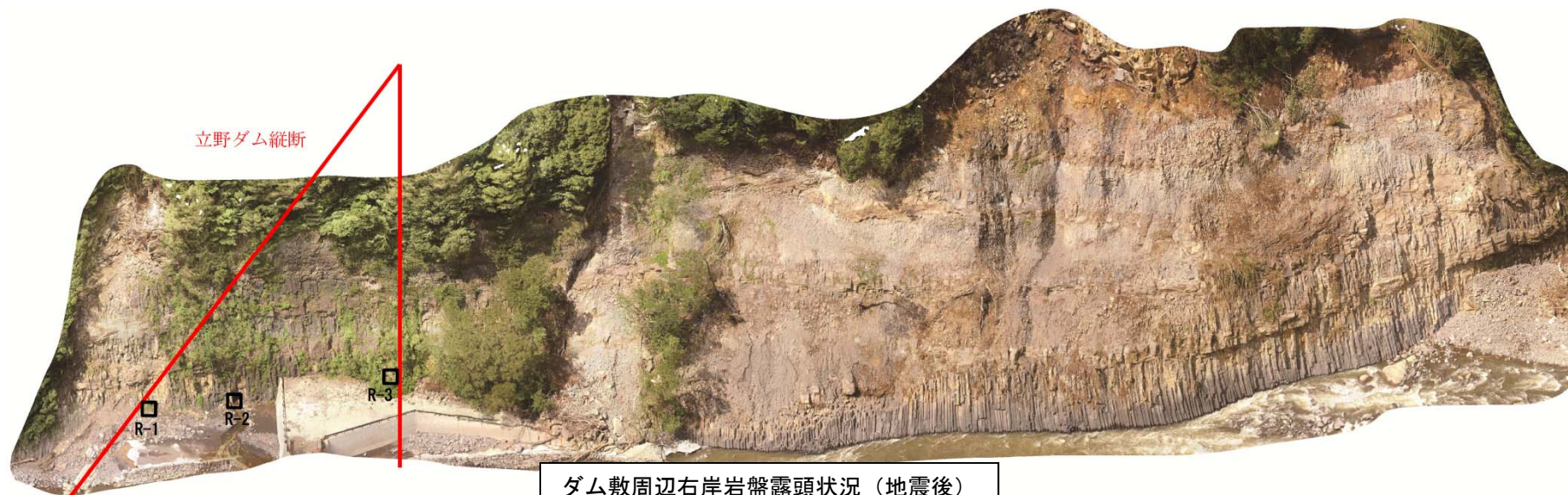
ダム敷周辺左岸岩盤露頭状況（地震後）
