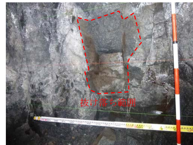
⑦入り口より 22.0m（下流側壁面）
