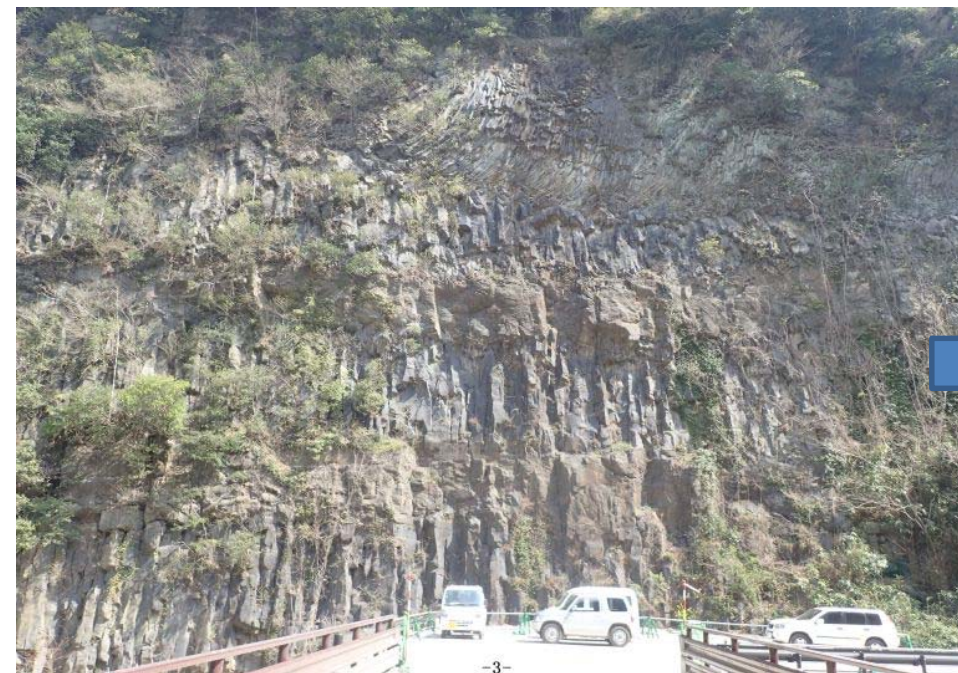
写真-4.3.2 ダムサイト右岸（地震前）
