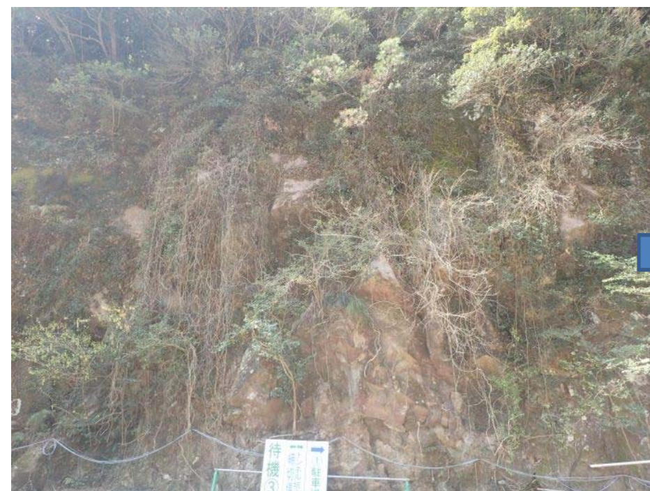
写真-4.3.4 ダムサイト左岸（地震前）
