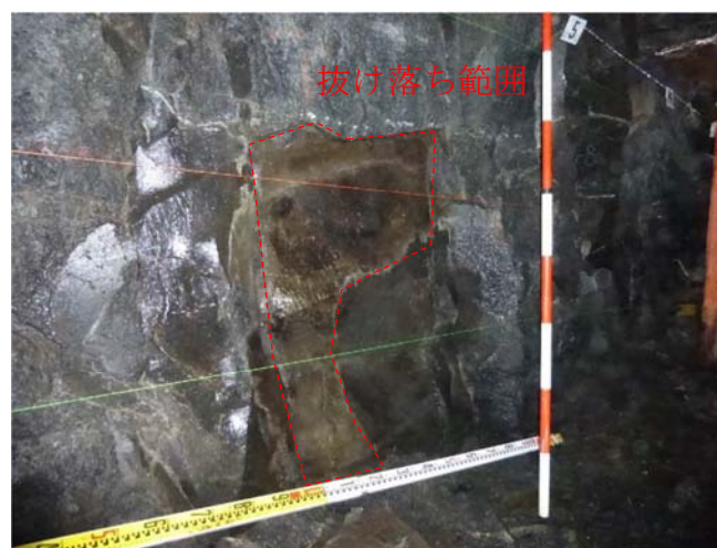
⑥入り口より 6.0m（上流側壁面）
