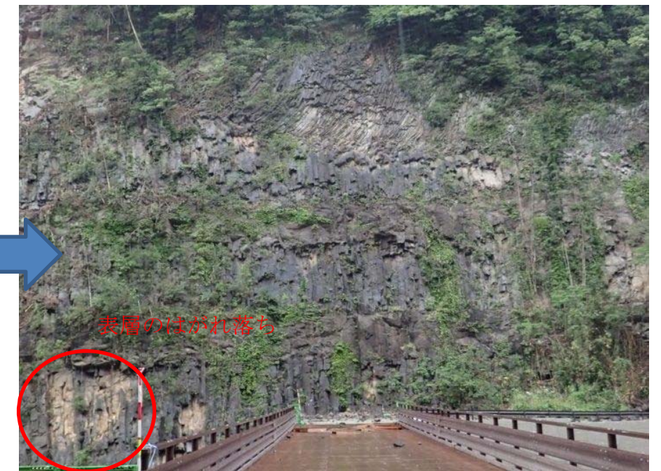
写真-4.3.3 ダムサイト右岸（地震後）
