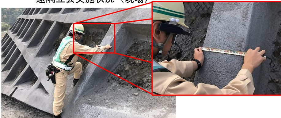
遠隔立会実施状況（現場）
