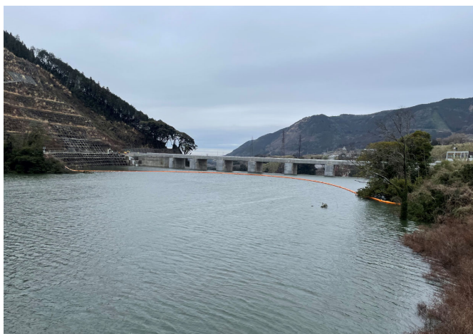
右岸からダム上流面を望む
