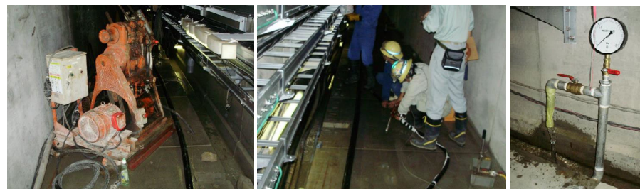
写真 他ダムにおける基礎排水孔削孔時の調査状況および基礎排水孔
