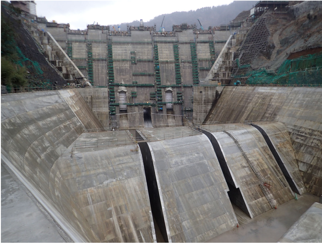
ダム下流側より
