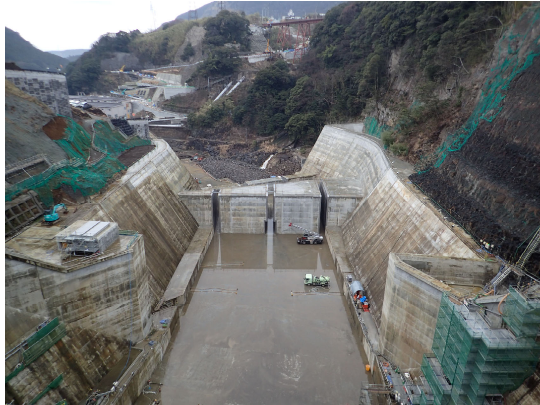
ダム堤体より減勢工側
