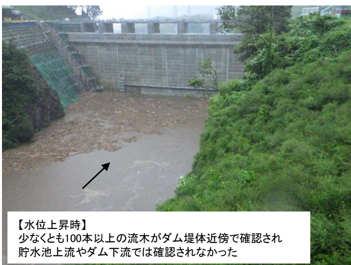
湛水状況 (R5.7.3 9:20頃)
