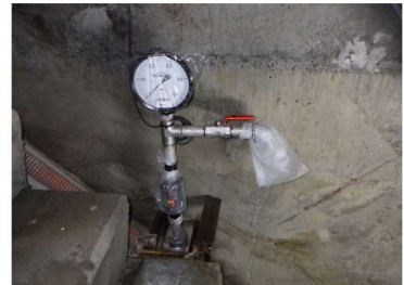
基礎排水孔(9-1孔) (濁りや排出物は確認されない)
