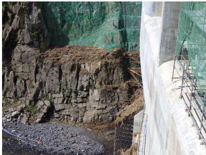
左岸状況 (R5.7.4 9:10頃)
