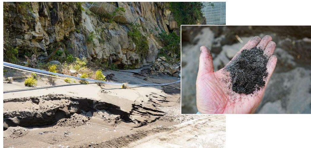
貯水池内の流速が小さくなる範囲を中心に砂が堆積(R5.7.6)
