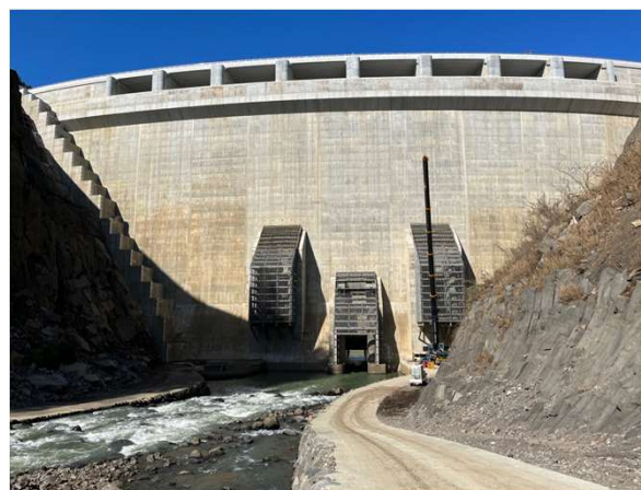
堤体に設置しているスクリーン (試験湛水後の状況)
