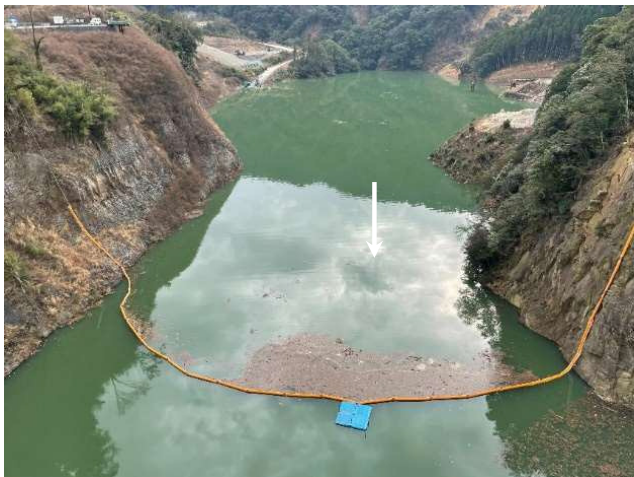
仮設網場による流木塵芥捕捉状況
