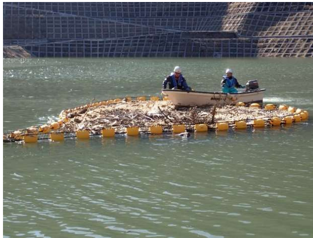
流木塵芥集積状況
