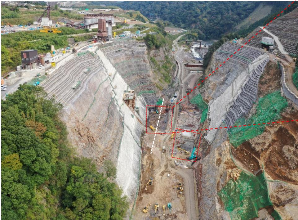
堤体基礎部追加掘削状況(令和2年10月)
