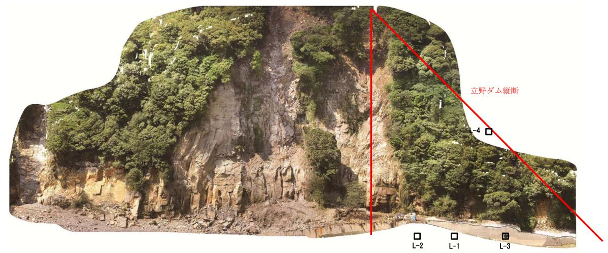
写真-5.3.7 ダムサイト左岸岩盤露頭状況 (地震後)
