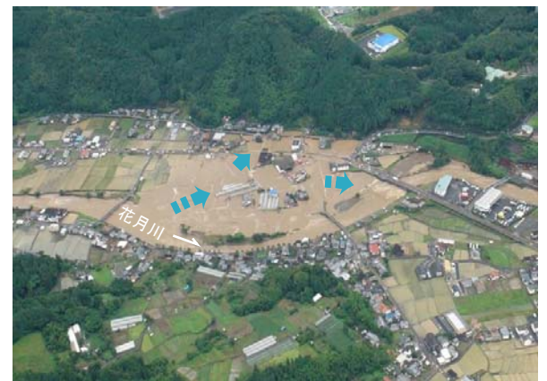
日田市三和地区 (花月川 7/700付近) 浸水状況 (平成24年7月3日 空撮)
