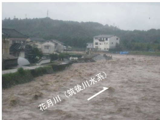
日田市西有田 坂本橋下流左岸の護岸崩壊状況 (平成24年7月14日 8:40)
