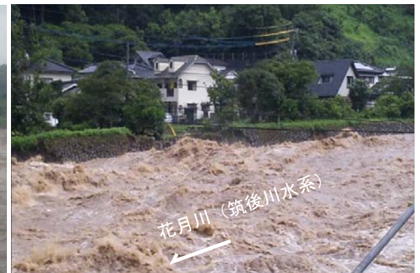
日田市三和 明德橋下流右岸の護岸崩壊状況 (平成24年7月14日 8:10)
