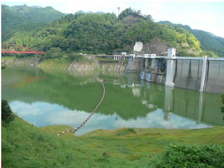
『ダム右岸よりダム湖を望む』
