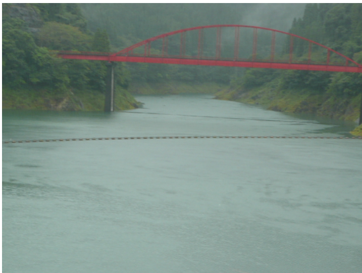
『ダム提体右岸より望む』
