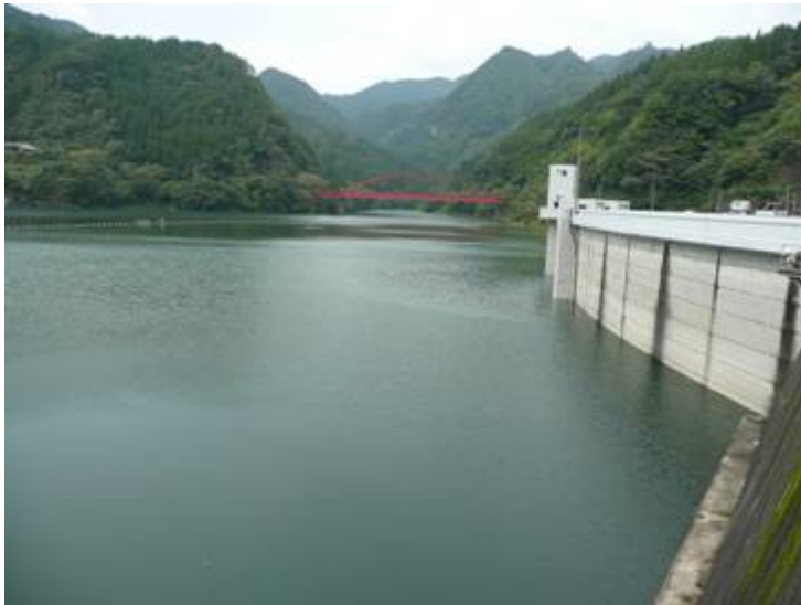
『ダム堤体右岸より望む』
