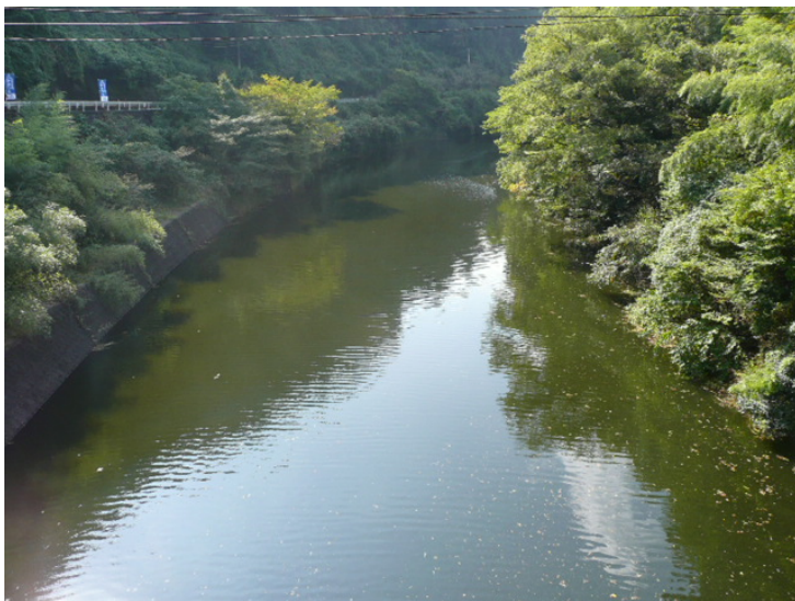
『新広川橋より上流を望む』
