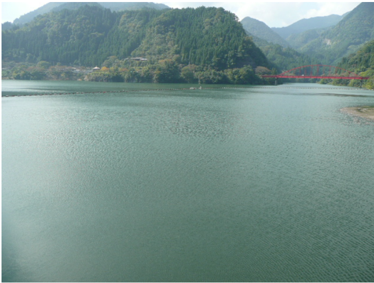
『ダム堤体右岸側より望む』
