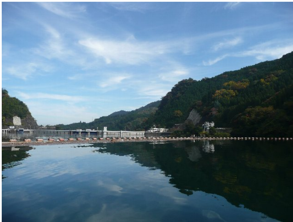
『上流よりダム堤体を望む』
