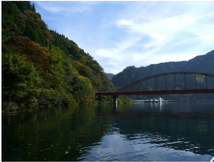
『川端橋下流より上流を望む』
